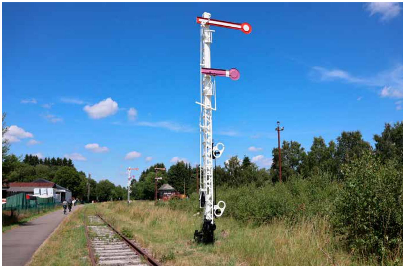
Signaux C1 et J1 restaurés en 2025, implantés à droite de la voie conformément à la circulation allemande, Sourbrodt. © A. Ferrière
